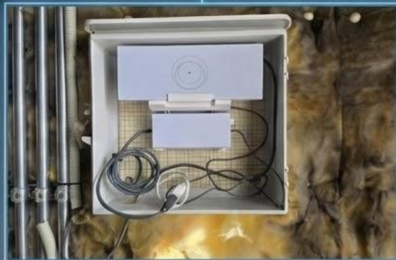
機器ボックス設置
