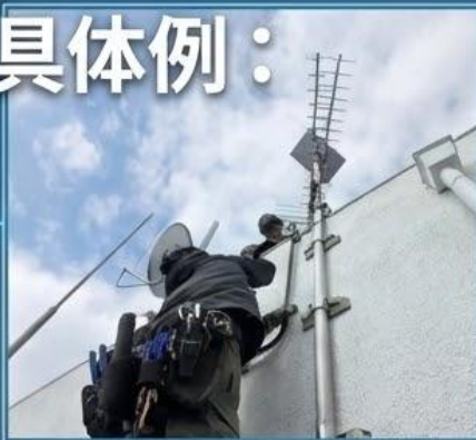
屋上アンテナ設置
