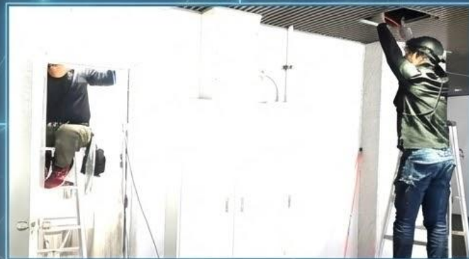
天井裏配線作業
