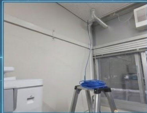
屋内ケーブル配線
