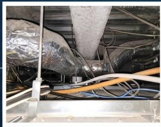
2. 天井裏の配線工事
